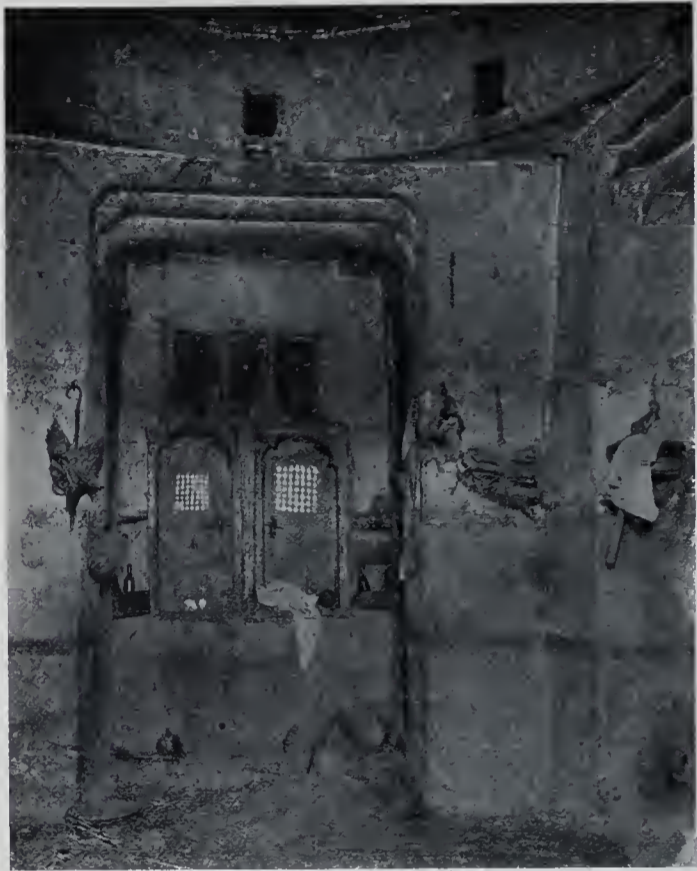
Abb. 124. Haus des Bäschä Gärzagjier zu Adua. Empfangsnische.
